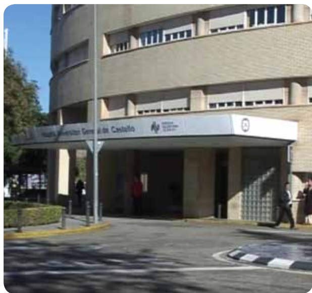
Fachada del Hospital General Universitario de Castelló.
