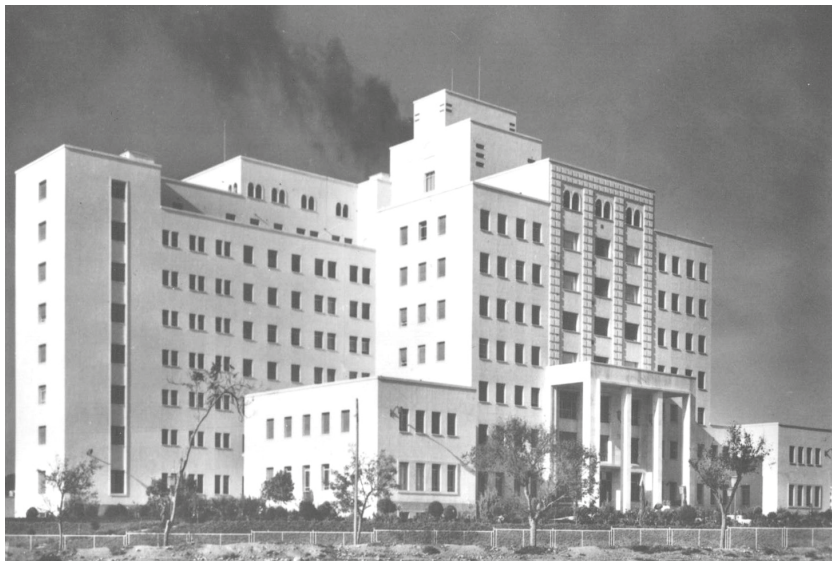
Vista de la primitiva Residencia Sanitaria (1955)
