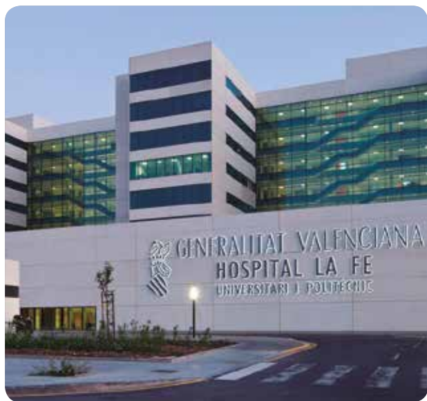
Fachada del Hospital Universitari i Politècnic La Fe de Valencia.
