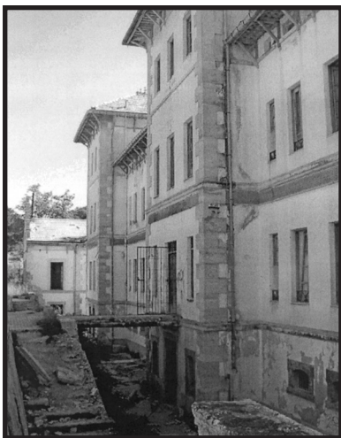
Vista del edificio principal y anexos
