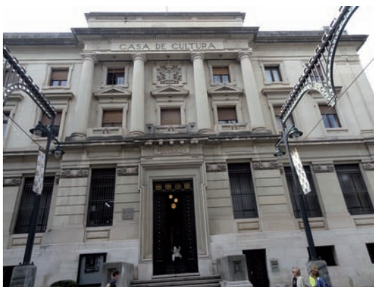
Fachada de la Casa de las Cultura de Alcoy (antiguo edificio del Banco de España) sede del Arxiu d'Alcoy.
