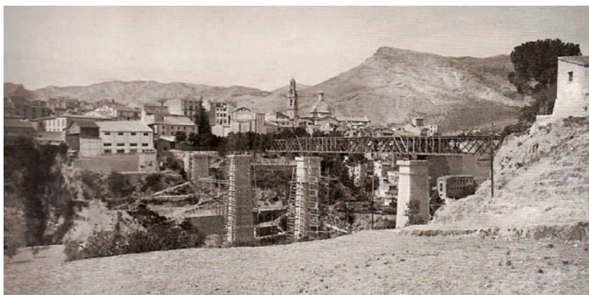
Vista de Alcoy a comienzos del siglo XX. En primer término el viaducto de Canalejas, en construcción. Fue inaugurado en 1907.
