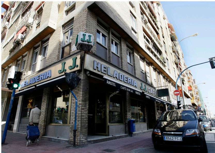
Foto 3: En el primer piso de este edificio de la urbanización Alipark se estableció la sede provisional del Colegio, a la espera de la finalización de las obras de del nuevo domicilio en la Avda. del Padre Vendrell, 11.
