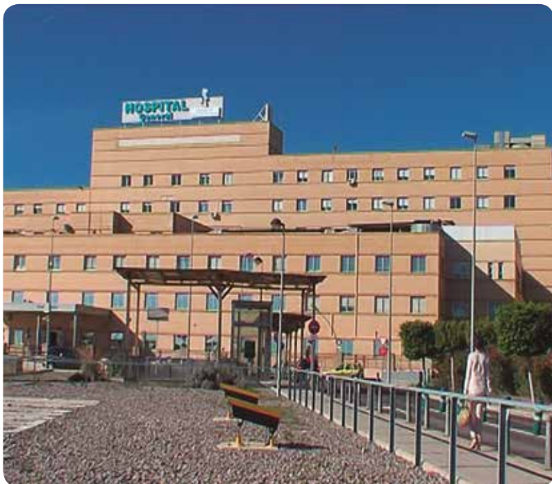
Imagen actual del Hospital General Universitario de Castellón.
