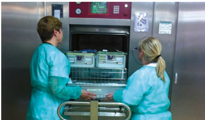
Imagen de la Central de Esterilización del Hospital General Universitario de Castellón
